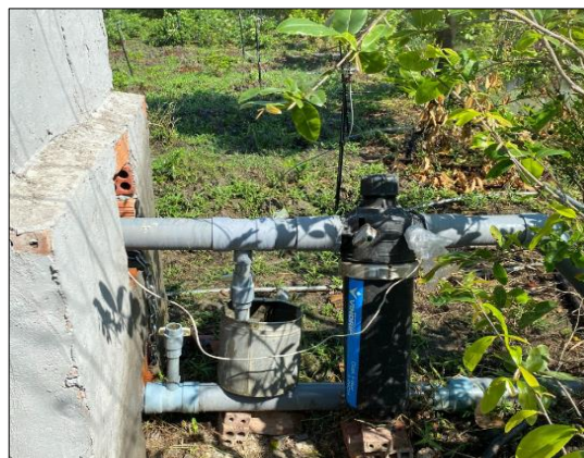
Hình 17. Thiết bị lọc và đồng hồ đo áp suất khi tưới
